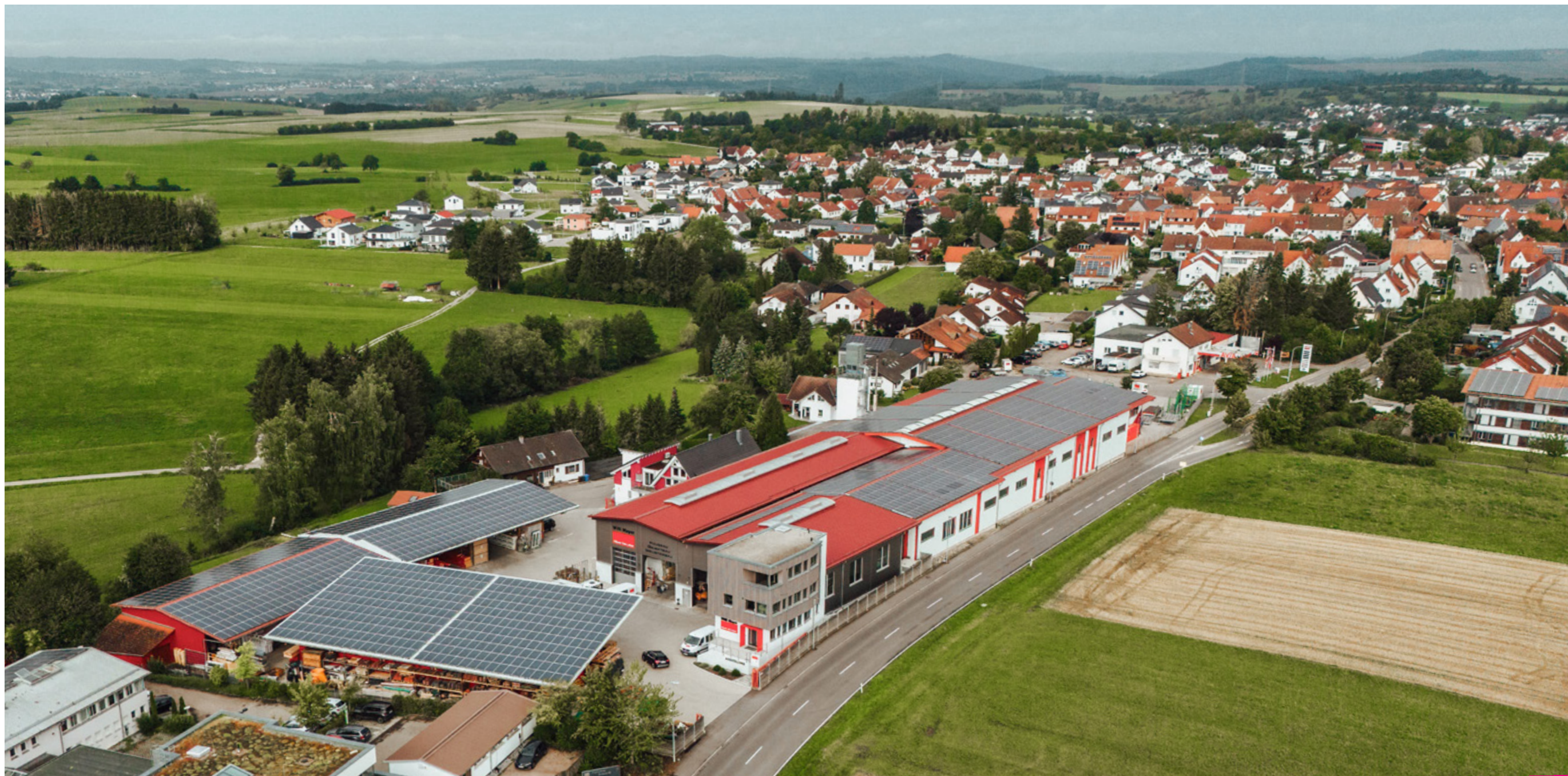
Betriebsgelände Willi Mayer, Bisingen
